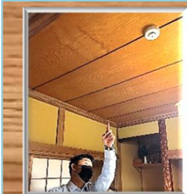
火災報知機の点検
