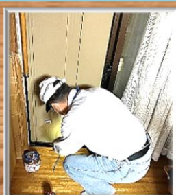
雨戸のカギの修理
